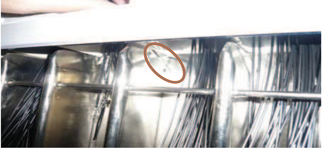
Şekil 4.9. Arkadan beslemeli kablo tesisatı montaj çalışma tezgahında kablo besleme noktası iyileştirme öncesi durum.
