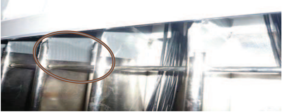
Şekil 4.10. Arkadan beslemeli kablo tesisatı montaj çalışma tezgahında kablo besleme noktası iyileştirme sonrası durum.
