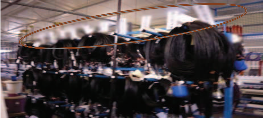
Şekil 4.12. Kablo tesisatı askı üniteleri iyileştirme sonrası durum.
