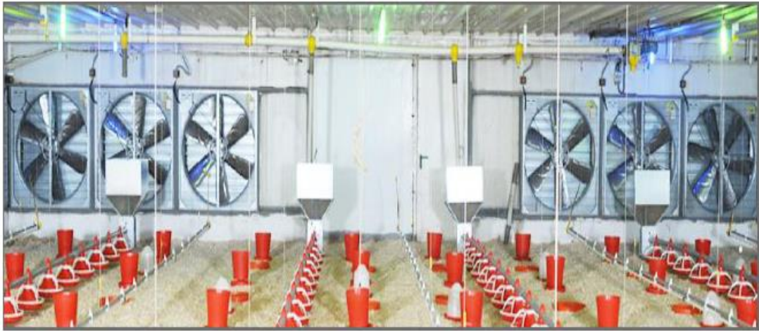
Şekil 3.1. Kümeste havalandırma sistemi
