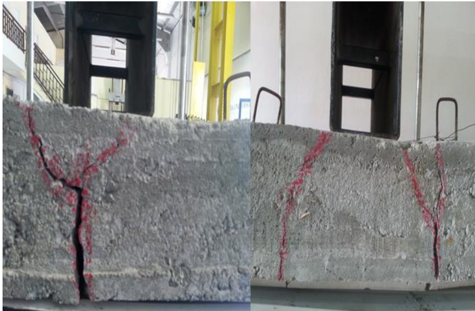
Şekil 3.42. DN3-2N-D150 numuneye ait ön ve arka çatlak görünüşleri
