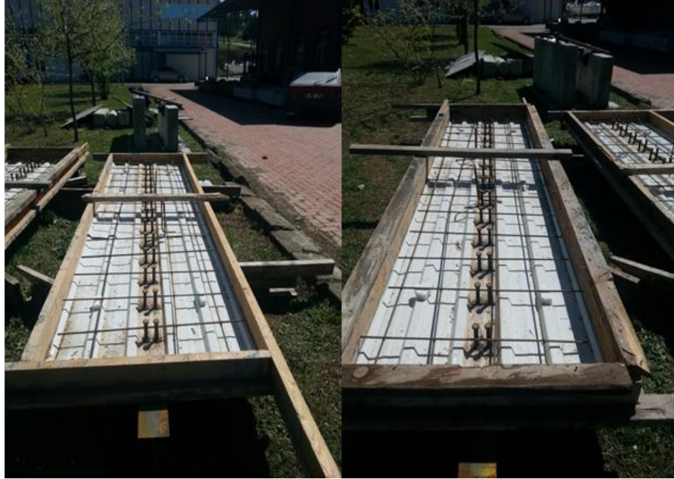
Şekil 3.20. Döşeme yükseklikleri farklı çift başlıklı saplama kalıp aşamalarında çekilen bazı resimler
