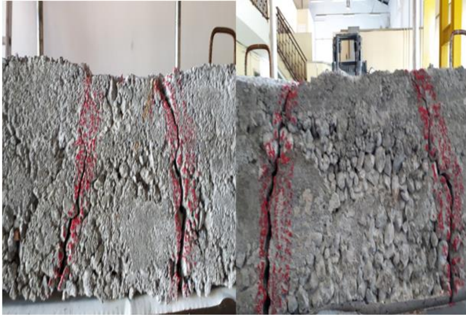
Şekil 3.48. DN4-1S-D150 numuneye ait ön ve arka çatlak görünüşleri
