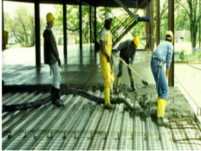
Şekil 2.2. Beton dökümü [18].
