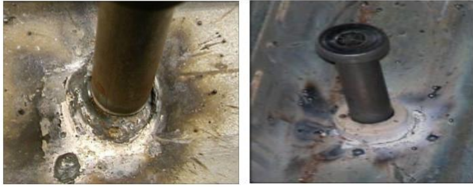
Şekil 2.10. Kaynaklanmış başlıklı kayma bağlantısı
