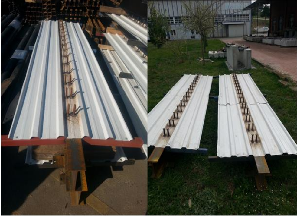
Şekil 3.21. Döşeme yükseklikleri farklı çiftli donatı çeliği ve başlıklı saplama aşamalarında çekilen bazı resimler
