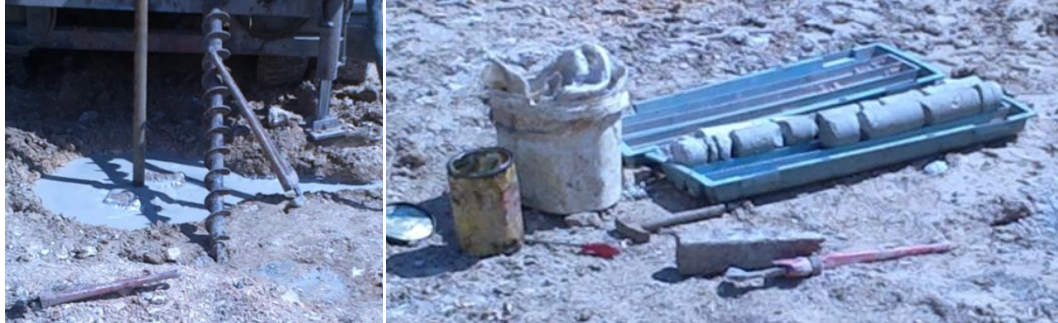
Şekil 3.17. Jet Grout kolonlarından alınmış karot numune alma
