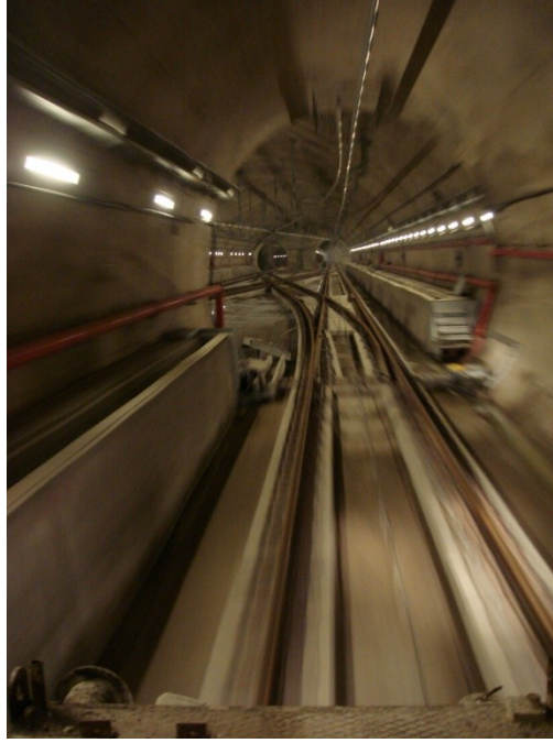
Şekil 2.4. Kartal-Kadıköy metro hattı tüneli
