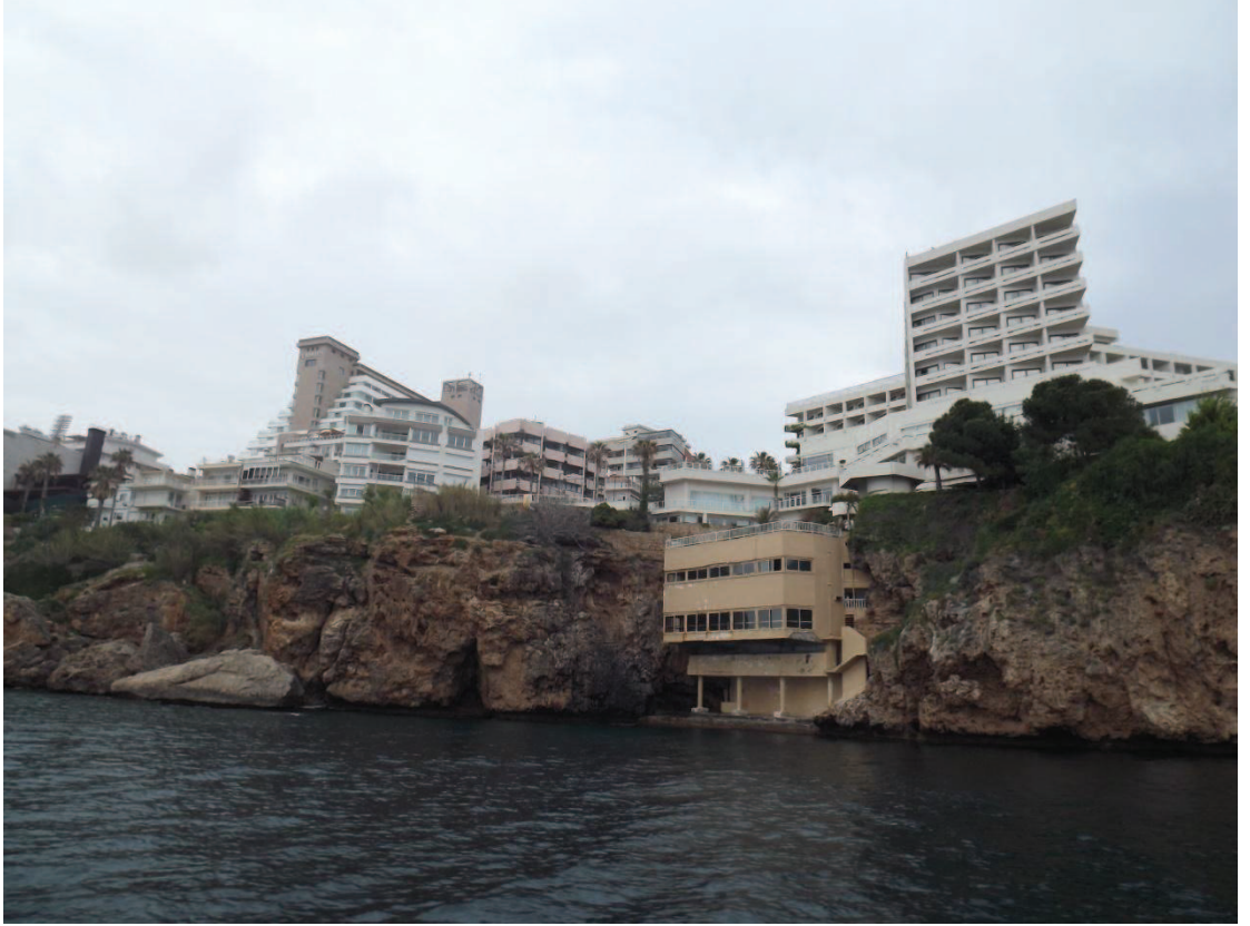
Fotoğraf 5: Antalya Kıyılarında Falezler Üzerine İnşa edilen Yapılar
