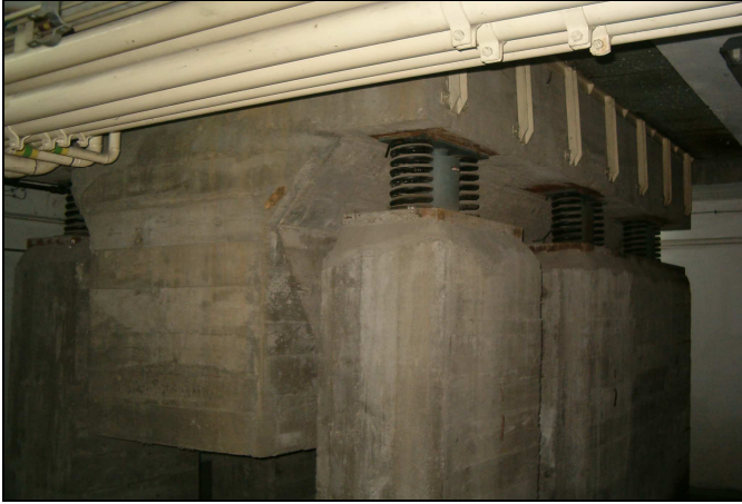
Şekil 6.3. Deney düzeneğinin altında bulunan çelik yaylar
