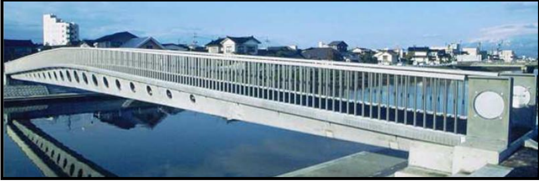
Şekil A.7. Sakata-Mirai RPB kullanılarak yapılan yaya köprüsü [37].
