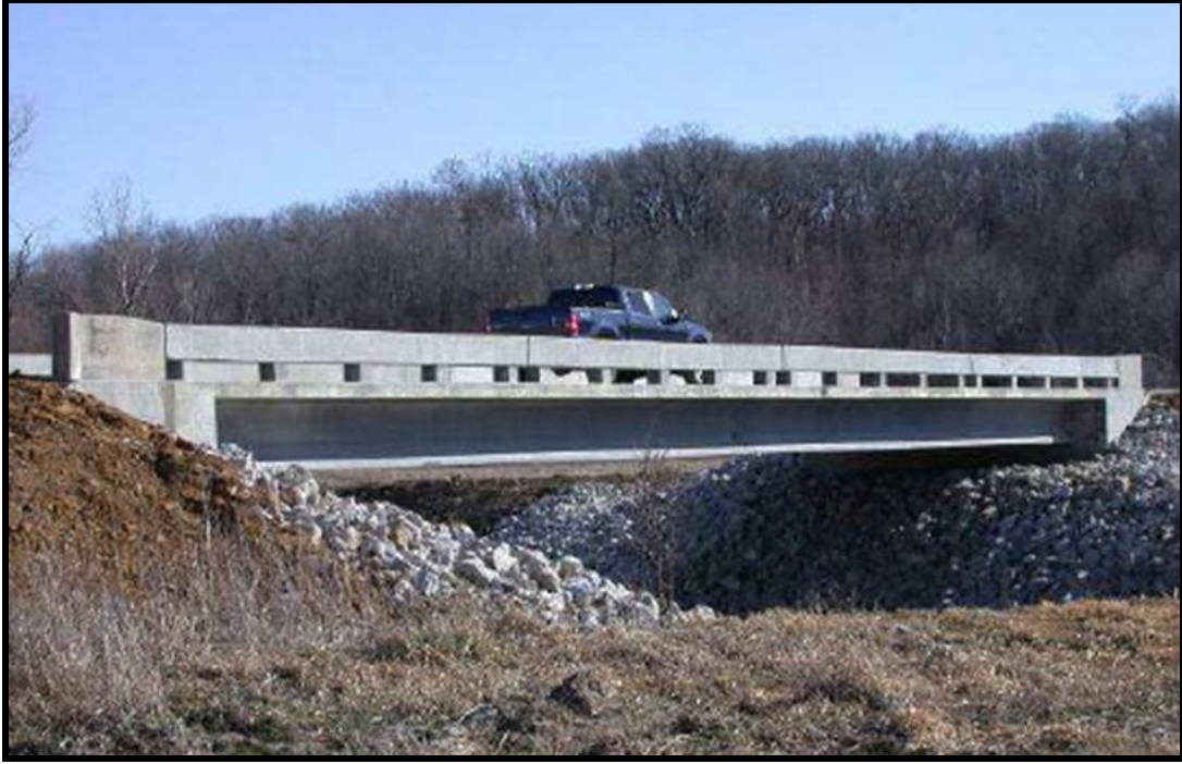
Şekil A.5. Wapello'daki, RPB kullanılarak yapılan şehir köprüsü [34, 35].
