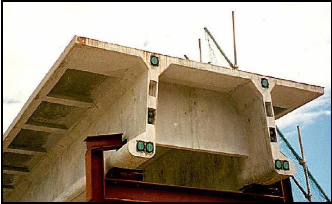
Şekil A.6. Sunyudo'da üzerinde RPB kullanılarak yapılan ilk köprü'nün kiriş resmi [36].
