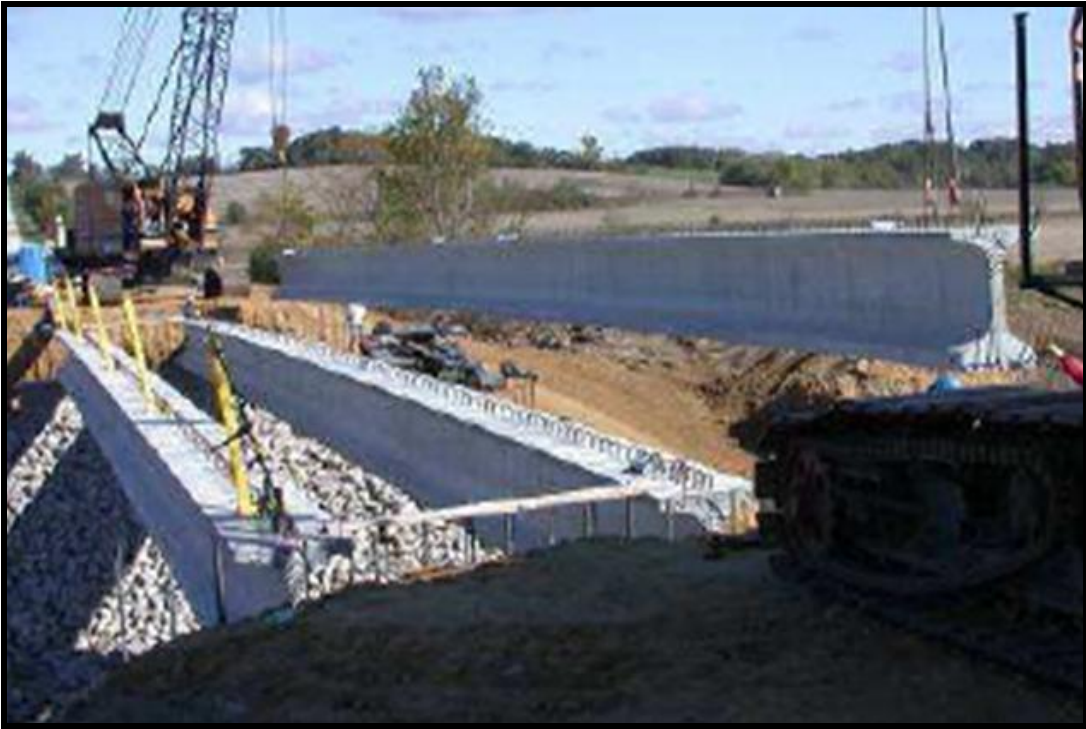
Şekil A.4. Wapello'daki, RPB kullanılarak yapılan şehir köprüsü kirişleri [34, 35].
