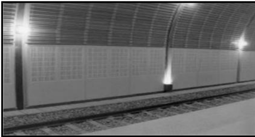
Şekil 2.17. RPB kullanılarak yapılan ses bariyeri [40].
