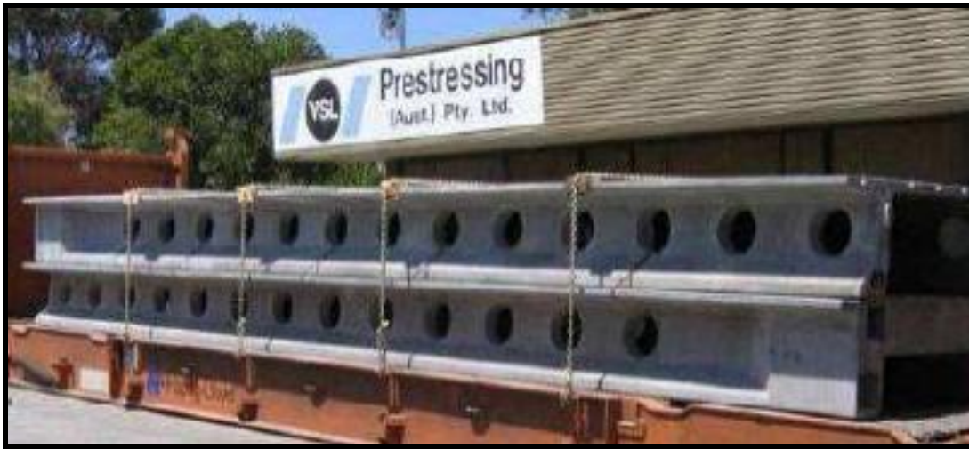
Şekil 2.14. Papatoetoe ve Penrose RPB kullanılarak yapılan üst geçit köprüsü kirişleri [38].
