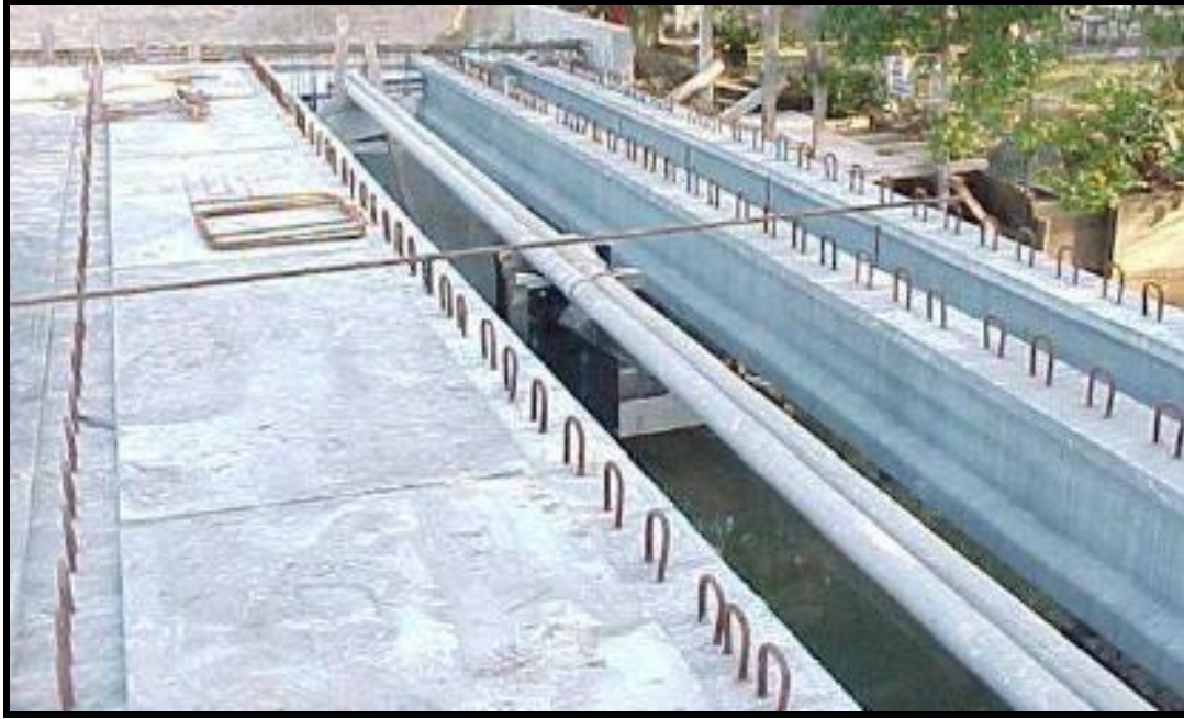
Şekil 2.8. Shepherds ırmağı üzerindeki, RPB kullanılarak yapılan ilk araç köprüsü kirişi [32].
