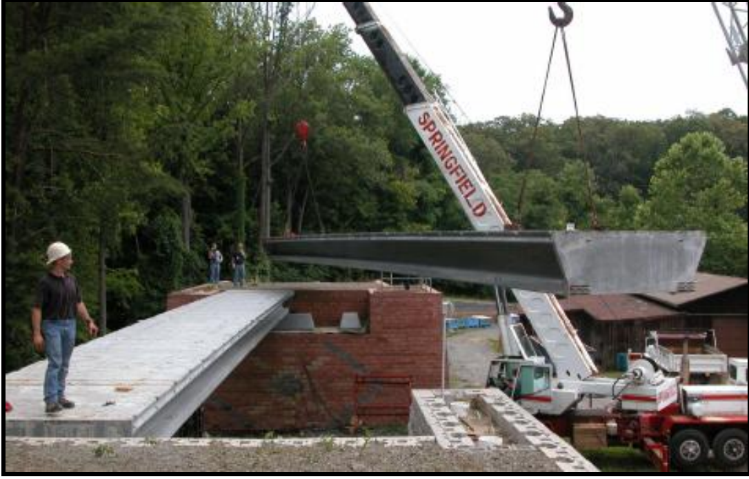
Şekil A.3. RPB'den araştırma amaçlı yapılmış köprü kirişleri [33].
