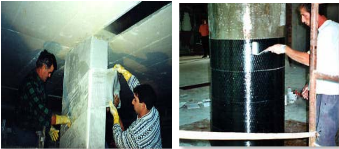
Şekil 2.8. Hasarlı Kolonların FRP ile Güçlendirilmesi
