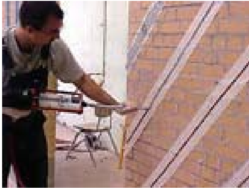
Şekil 2.12. FRP Kumaşların Duvarlarda Kullanımı
