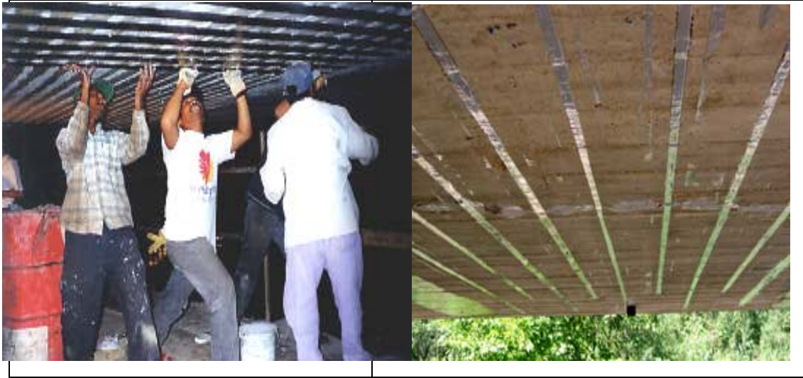
Şekil 2.11. Döşemelerde FRP Laminat Uygulaması
