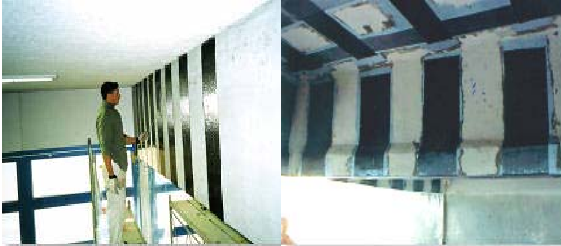
Şekil 2.10. Kirişlerde Kesmeye Karşı U Şeklinde Dilimler Halinde FRP Uygulaması
