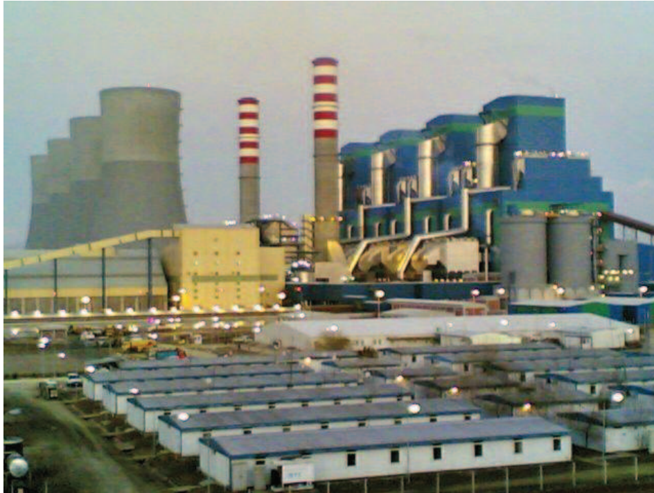
Şekil 2.7. Bir termik santralin fiziksel görünümü
