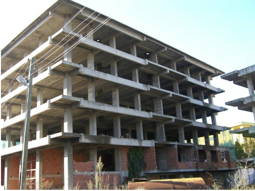
Şekil 5.17. Dayal İnşaat A blok fotoğrafı [98]
