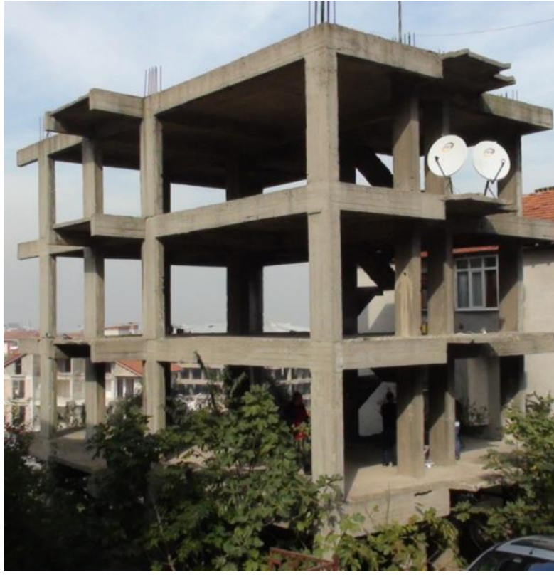
Şekil 5.31. Hikmet Şahin Apartmanı fotoğrafı [98]
