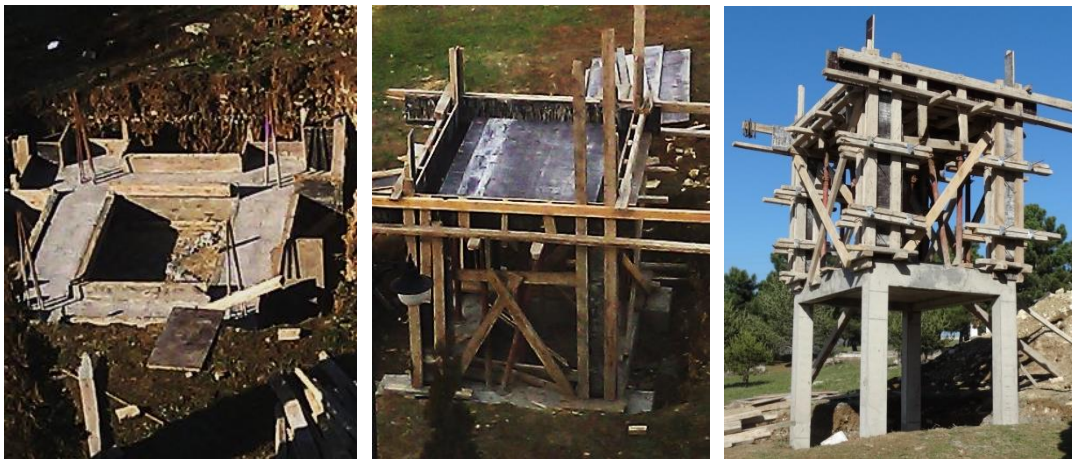
Şekil 3.4. Test binasının inşa aşamaları
