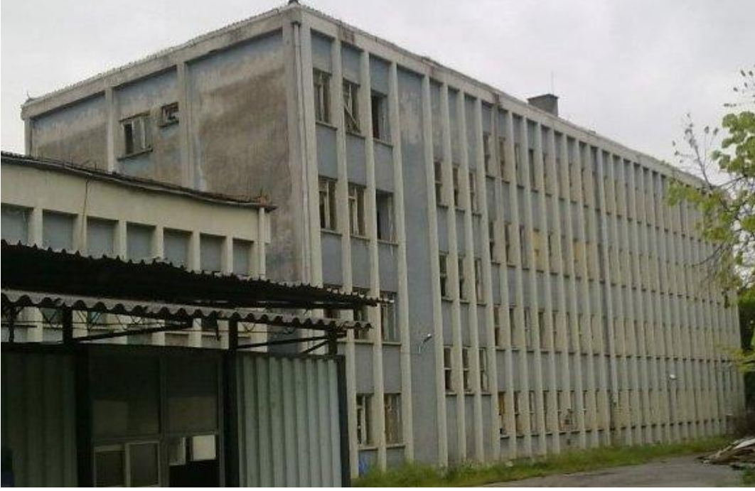
Şekil 5.45. SSK Hizmet Binası fotoğrafı [98]
