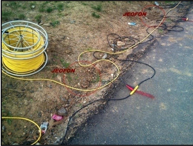
Şekil 5.10. Çalışmada jeofonların zemine yerleştirilmesi
