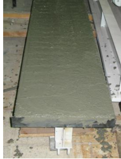
b) Tabliye betonu tesviye edilmiş hali
