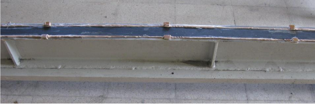
Şekil 3.17. Çelik kirişe HM-CFRP yapıştırılması
