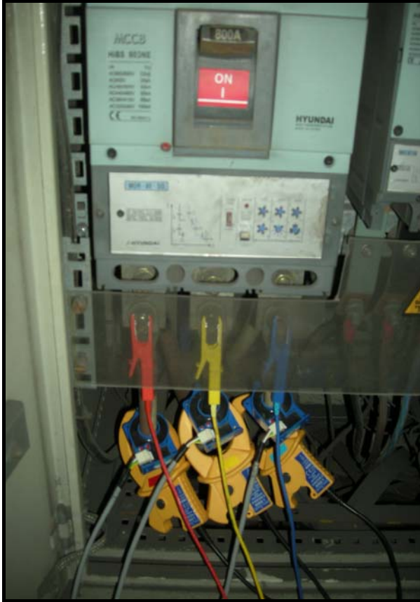
Şekil 5.9. İndüksiyon fırınının beslemesine ait yapılan ölçüm bağlantıları
