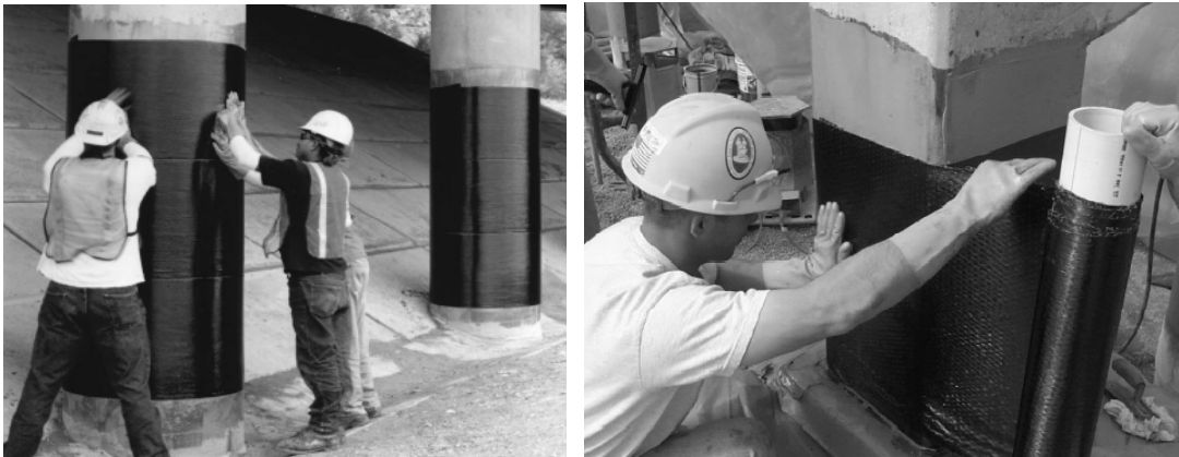
Şekil 1.4. Hasarlı kolonların FRP ile onarım ve güçlendirilmesi
