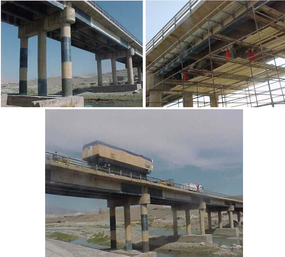
Şekil 1.2. Göksü Köprüsü güçlendirme çalışması
