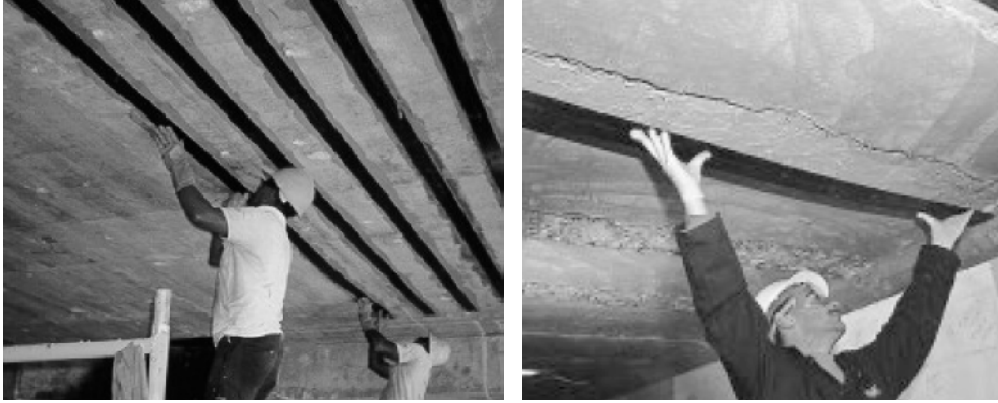
Şekil 1.6. Döşemelerde FRP laminat uygulaması
