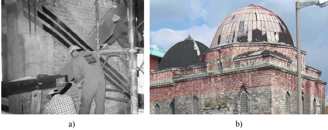
Şekil 1.7. FRP dokumaların duvarlarda ve tarihi yapılarda kullanımı
