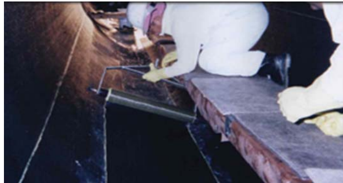
Şekil 1.8. Boru içi FRP uygulaması
