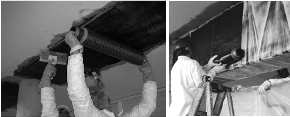
Şekil 1.5. Kirişlerde eğilme ve kesmeye karşı FRP uygulaması
