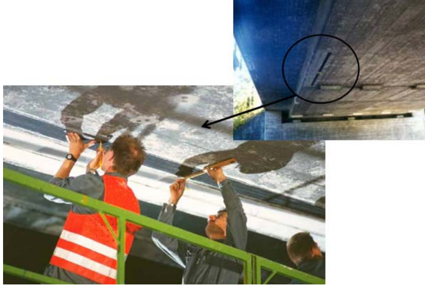
Şekil 1.1. Ibach Köprüsü CFRP plaka uygulaması
