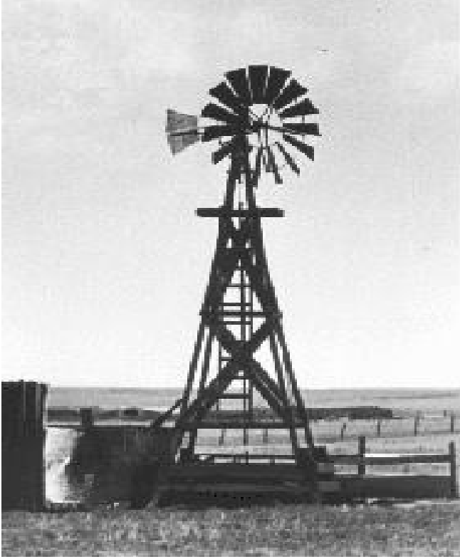
Şekil 3.14. Su pompalamak için kullanılan çok kanatlı bir rüzgar türbini [31]
