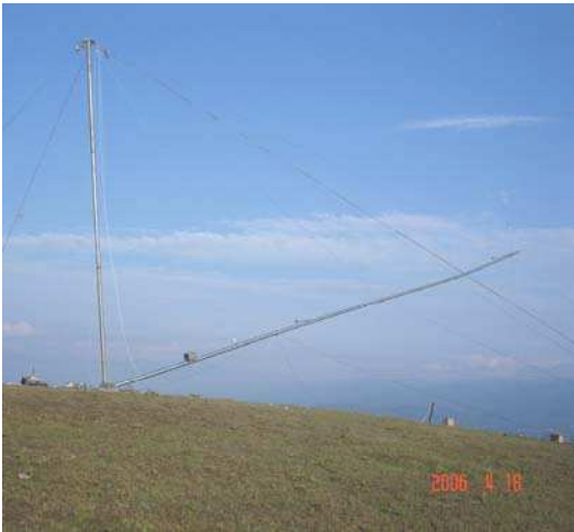
Şekil 4.3. Sakarya-Esentepe rüzgar ölçüm istasyonu montaj aşamaları
