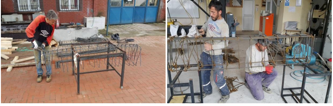
Şekil 5.3. Donatıların hazırlanması
