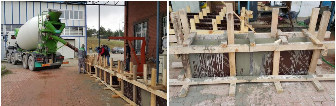
Şekil 5.5. Beton dökülmesi
