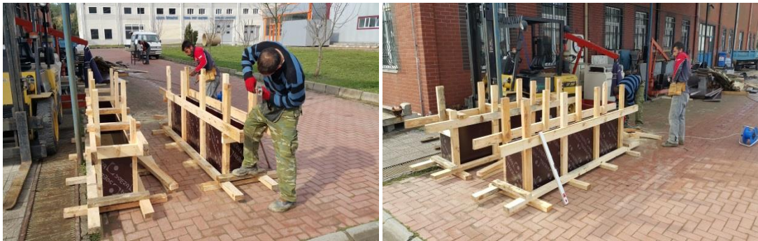
Şekil 5.2. Kalıpların hazırlanması
