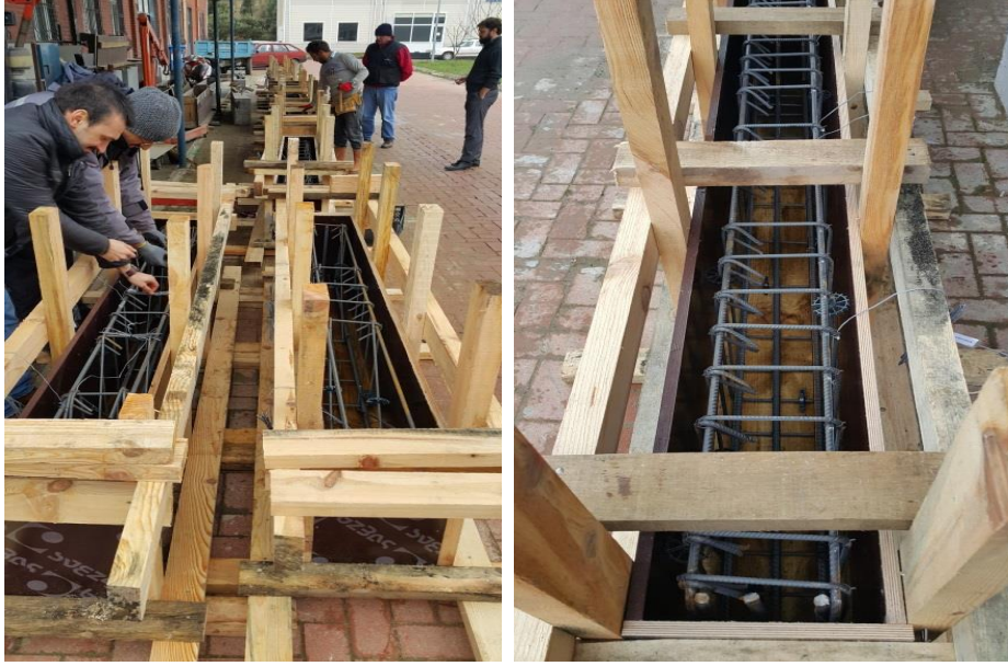
Şekil 5.4. Donatıların kalıplara yerleştirilmesi
