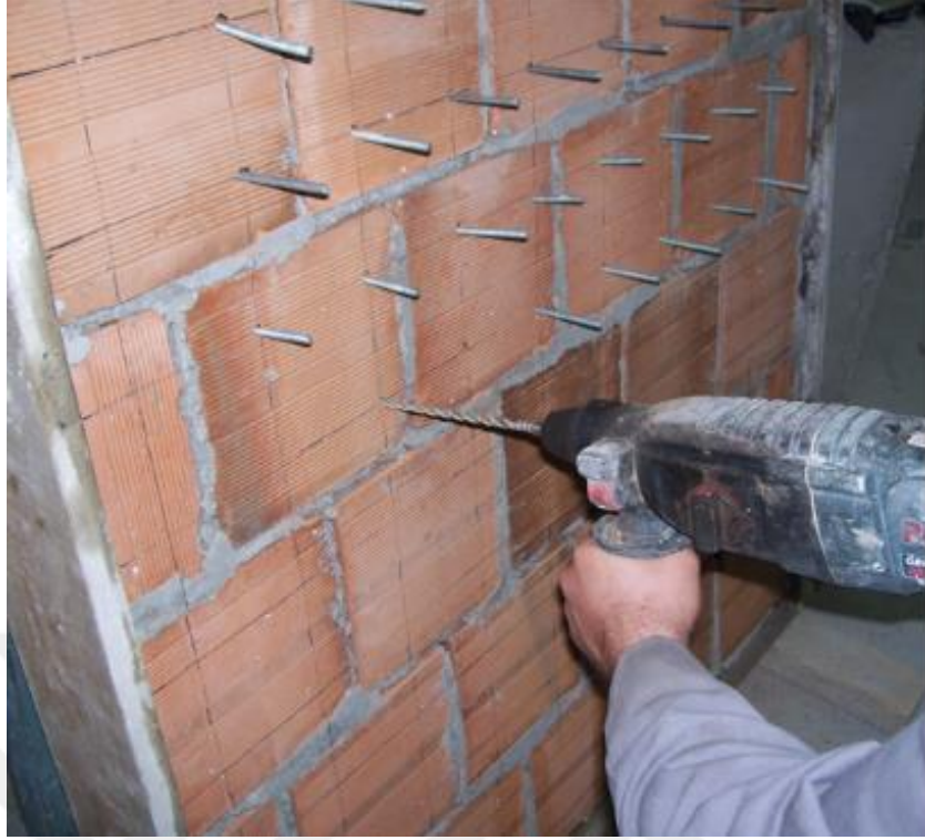
Resim 3.2. Deney elemanlarının yapım aşamasında bulon deliklerinin açılması
