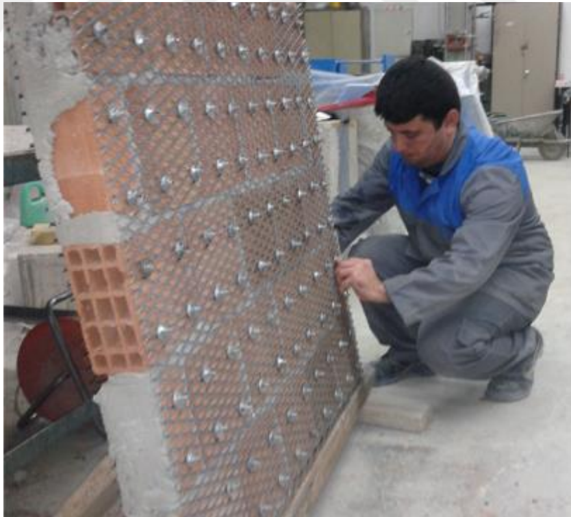
Resim 3.3. Deney elemanlarının yapım aşamasında bulon montajlarının yapılması
