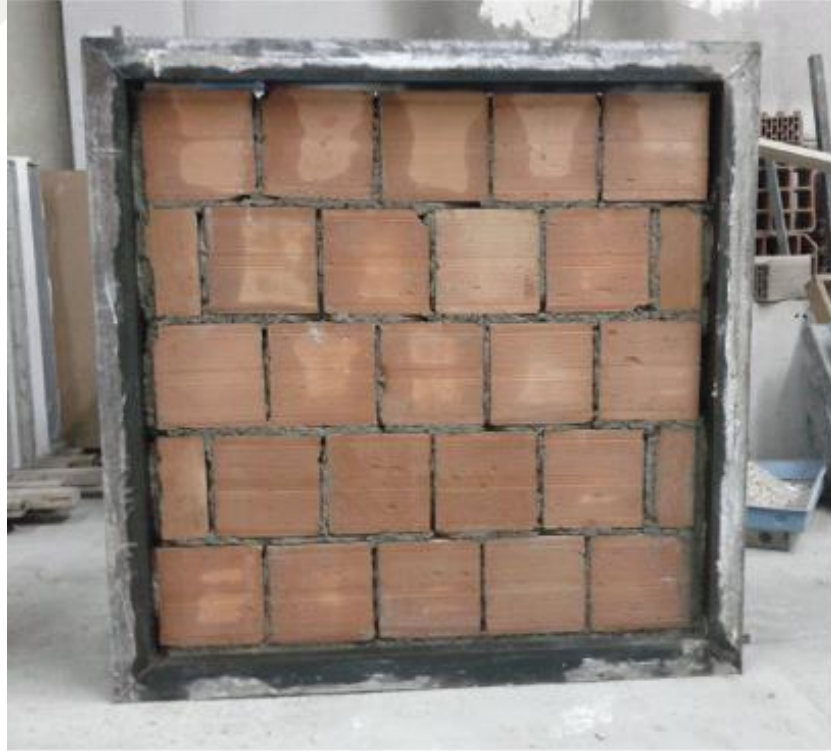
Resim 3.1. Deney elemanlarının yapım aşamasında tuğla duvar örülmesi
