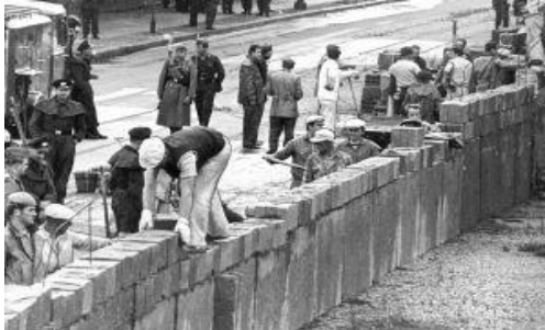
Resim 21. Duvarın Çöküşü ( URL,29)
