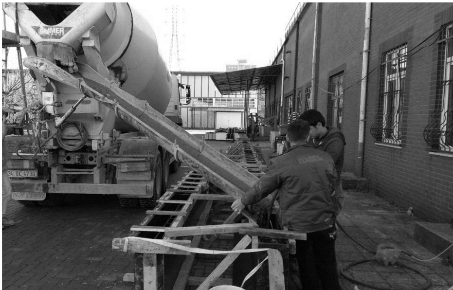
Şekil 5.13. Betonun kalıba yerleştirilmesi.
