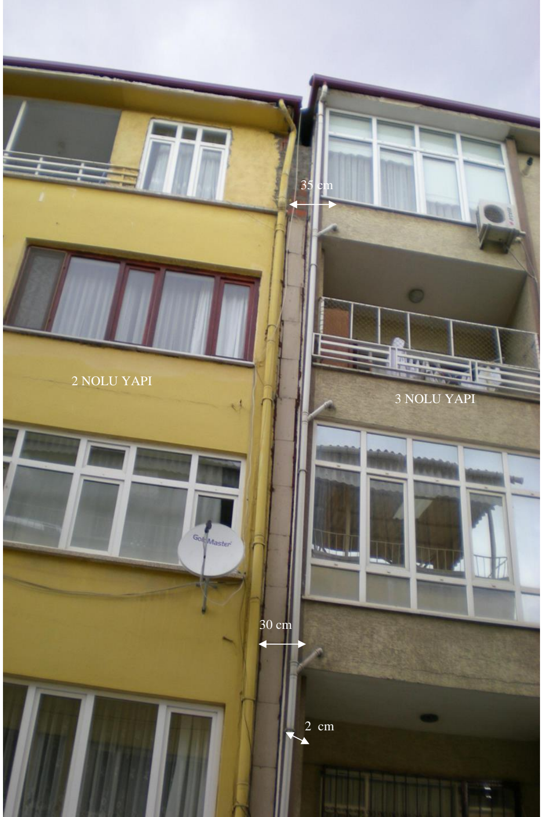
Şekil 3.9. Güçlendirme sonrası (2) ve (3) nolu binaların günümüzdeki birleşim yeri (30-35 cm birbirinden ayrık ve (3) nolu bina 2 cm önde)
