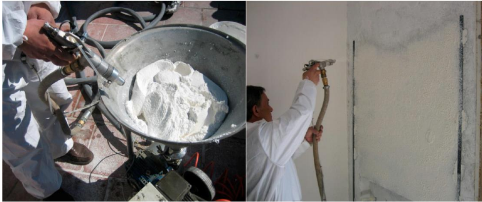
Şekil 2.10. Granüler aerojel bazlı sıvanın cephelerde kullanımı [72].
