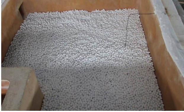
Şekil 2.19. Derin Yatak Filtreleme Ünitesi (DBF) ve içerisinde bulunan alümina toplar [36].
