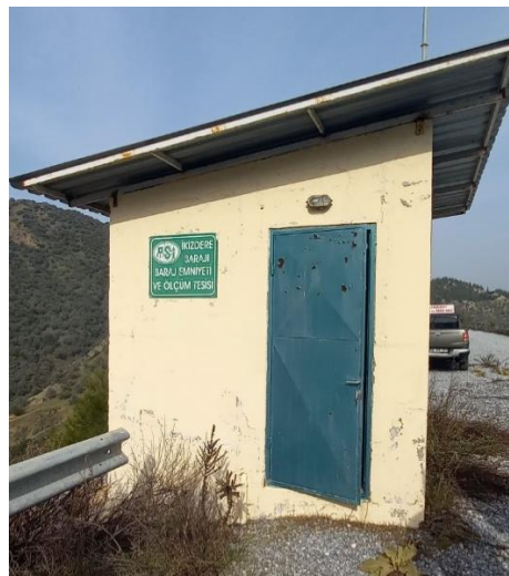
Şekil 4.18. İkizdere Barajına ait baraj emniyeti ve ölçüm tesisi odası.
