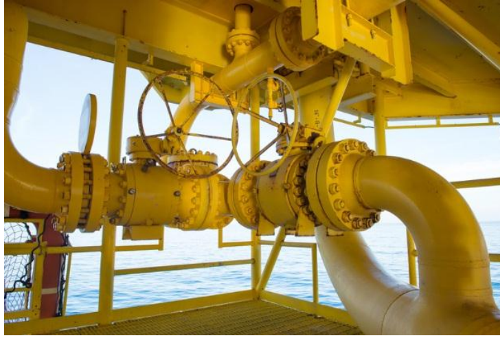
Şekil 2.1. Petrokimyasal Komplekslerde Küresel Vanalar.
