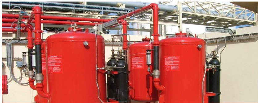
Şekil 2.14. Sabit kuru kimyasal söndürme sistemleri
