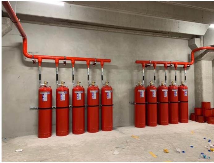
Şekil 2.15. FM200 gazlı yangın söndürme sistemleri
