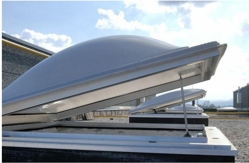
Şekil 2.10. Duman tahliye sistemleri
