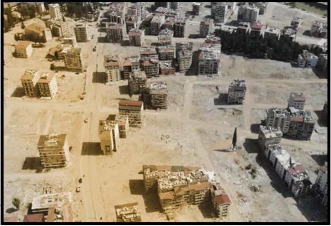
Şekil 3.4. Yıkılan Binalar kaldırıldı (Mynet,2023).
