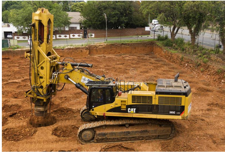
Şekil 2.6. Hızlı darbeli kompaksiyon (RIC) uygulaması.
