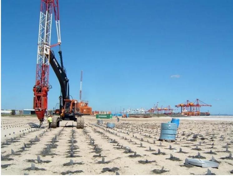
Şekil 2.16. Düşey dren uygulaması.
