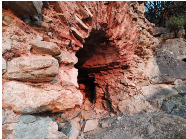
Görsel 21: Kalenin Güneybatı Tarafındaki Tuğla Kemerli Girişi
