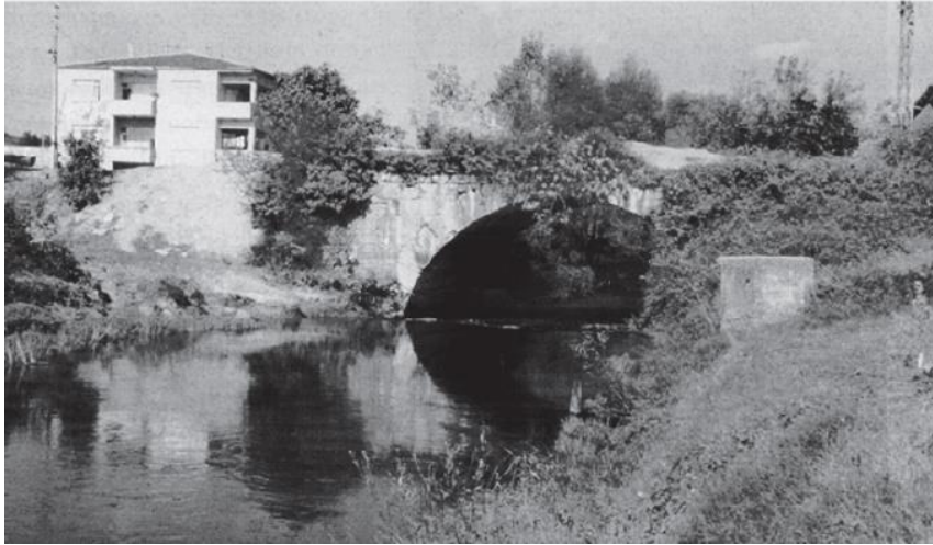
Görsel 13: Çarksuyu Üzerinde Bulunan Küçük Justinianus Köprüsü
