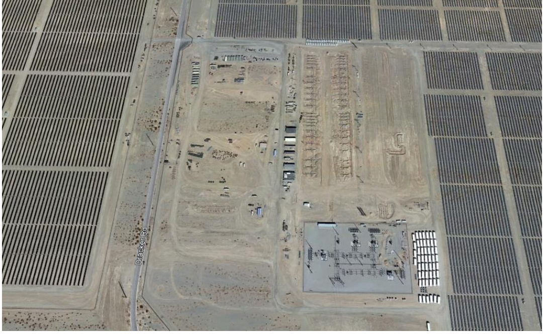
Şekil 1.1. 485 MW Blythe Solar Complex, 387 MW batarya depolamalı on-grid GES uygulaması, 2022, A.B.D.[3]
