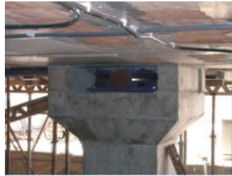
Şekil 2.7. Kocaeli Üniversitesi Tıp Fakültesi Binası taban izolasyon uygulaması (Kan ve ark, 2017).
