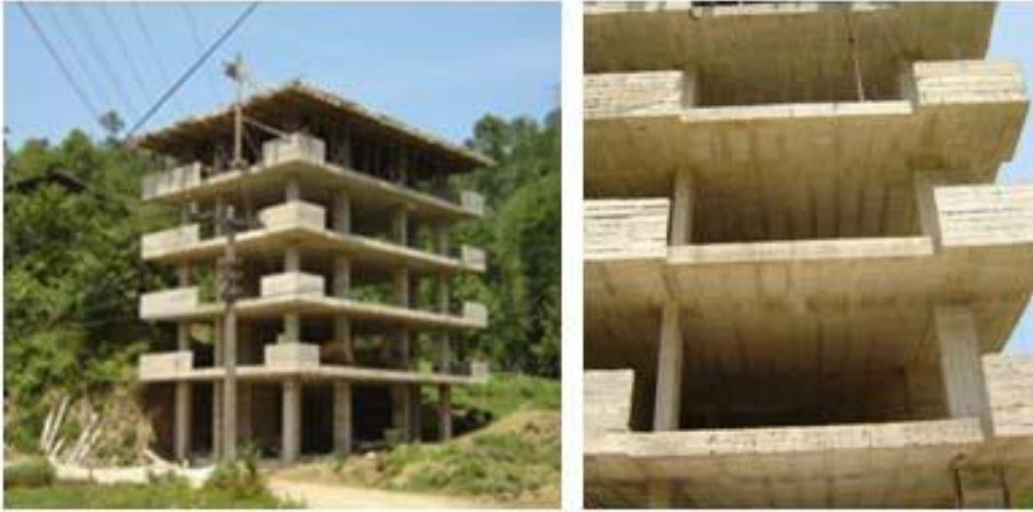
Şekil 5.2. Beş katlı betonarme binanın ölçüm alınan karkas durumu.
