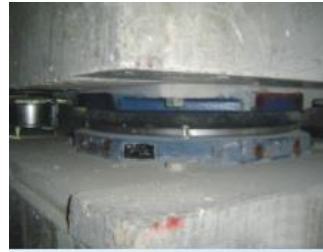
Şekil 2.7. Kocaeli Üniversitesi Tıp Fakültesi Binası taban izolasyon uygulaması (Kan ve ark, 2017).
