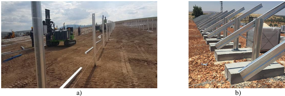
Şekil 3.5.a) Panel taşıyıcı destek yapılarının çakma yöntemi ile montajı b) Panel taşıyıcı destek yapılarının betonarme yapı ile montajı
