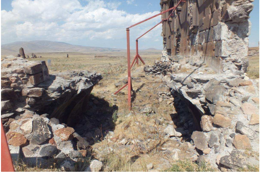
Fot. 3: Gürcü Kilisesi, toprak seviyesi altındaki kat.
