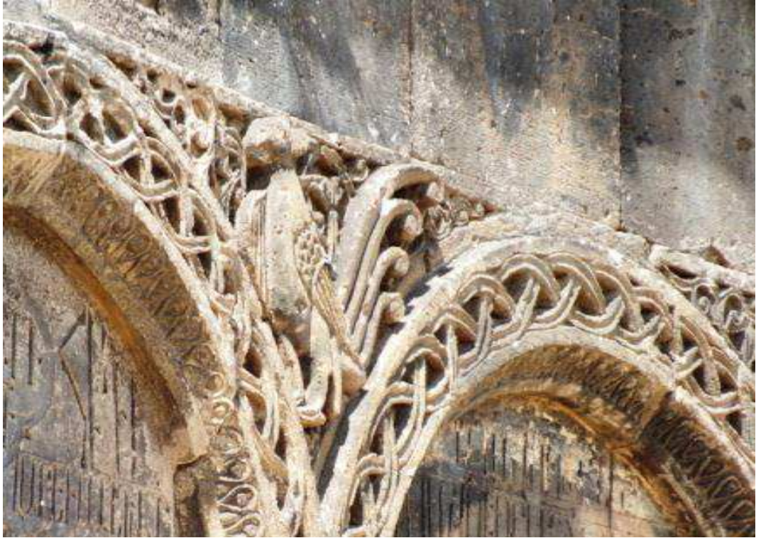
Fot. 80: Resimli Kilise, güney cephe horoz kabartması.
