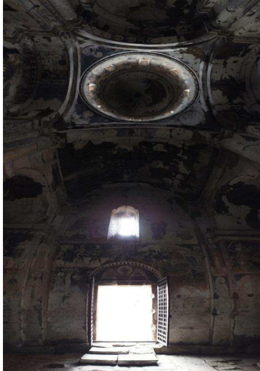
Fot. 56: Resimli Kilise, iç narteks kuzey ve güney tonoz başlangıçları, naos kuzey ve güney geniş kemer örtüleri, kubbe geçiş elemanları, kubbe ve taşıyıcılar.
