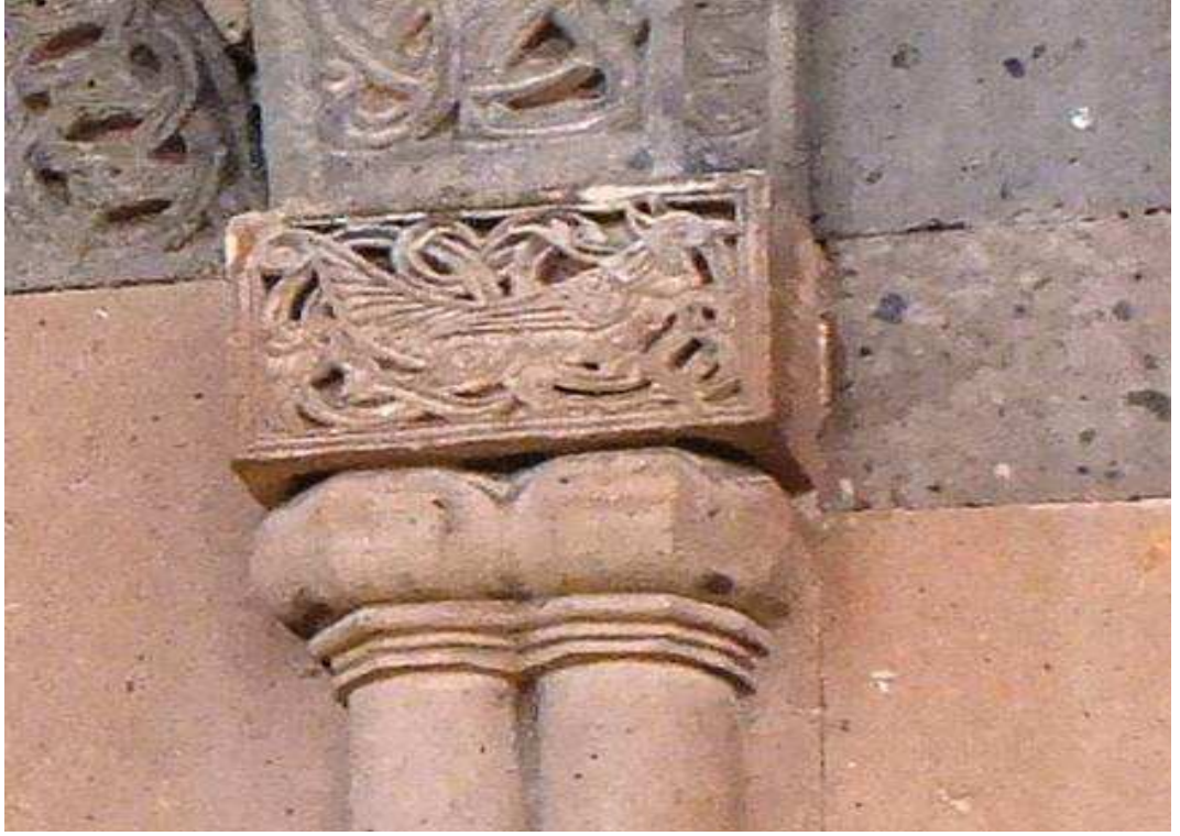
Fot. 85: Resimli Kilise, dođu cephe baykuř kabartması.
