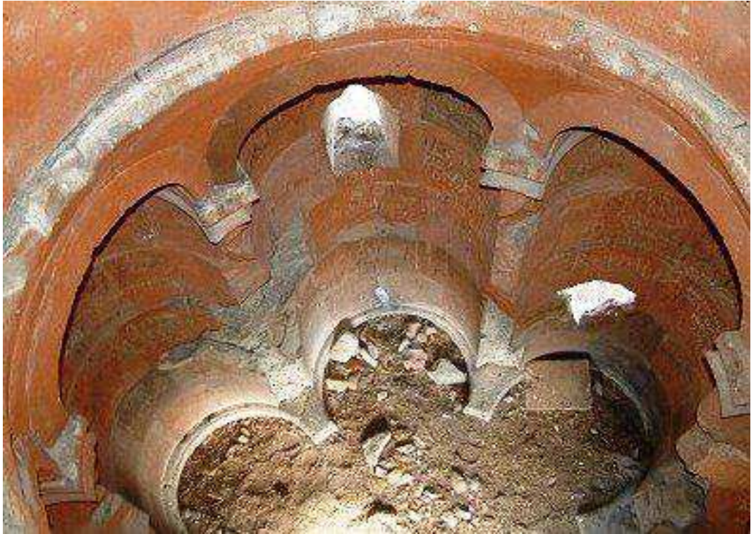
Fot. 18: Gen Kızlar Kilisesi, i yapı.
