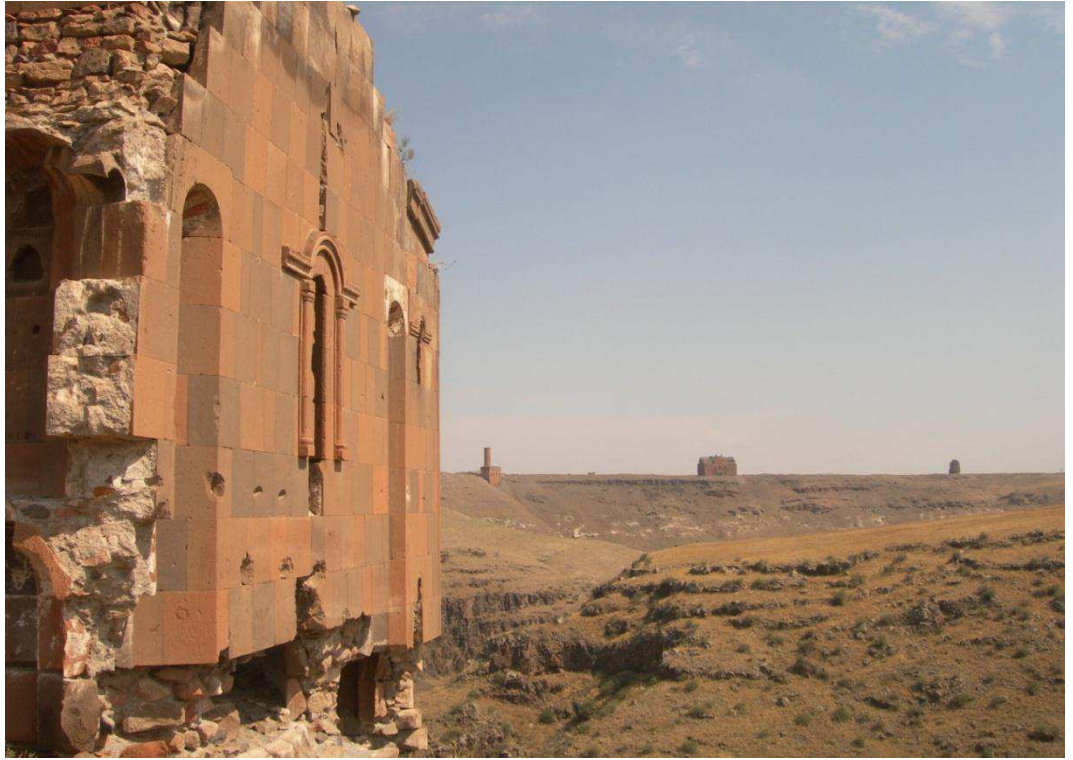
Fot. 38: Kızlar Kilisesi, doğu cephesi.
