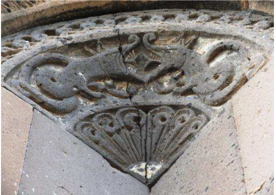
Fot. 78: Resimli Kilise, güney cephe ejder kabartmaları.
