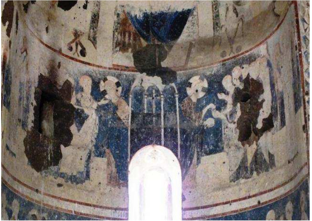
Fot. 190: Resimli Kilise, apsis duvar resmi. Havarilerin Komünyonu.
