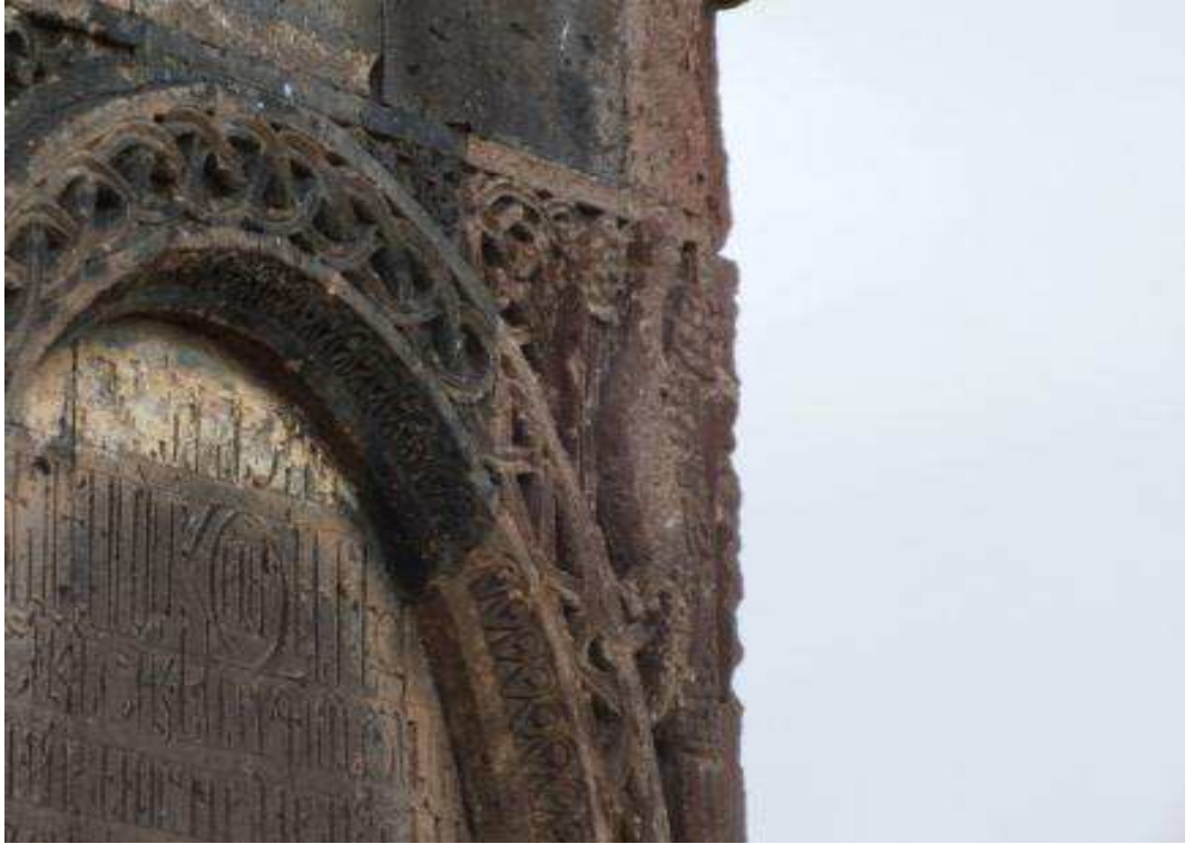
Fot. 82: Resimli Kilise, güney cephe şahin kabartması.
