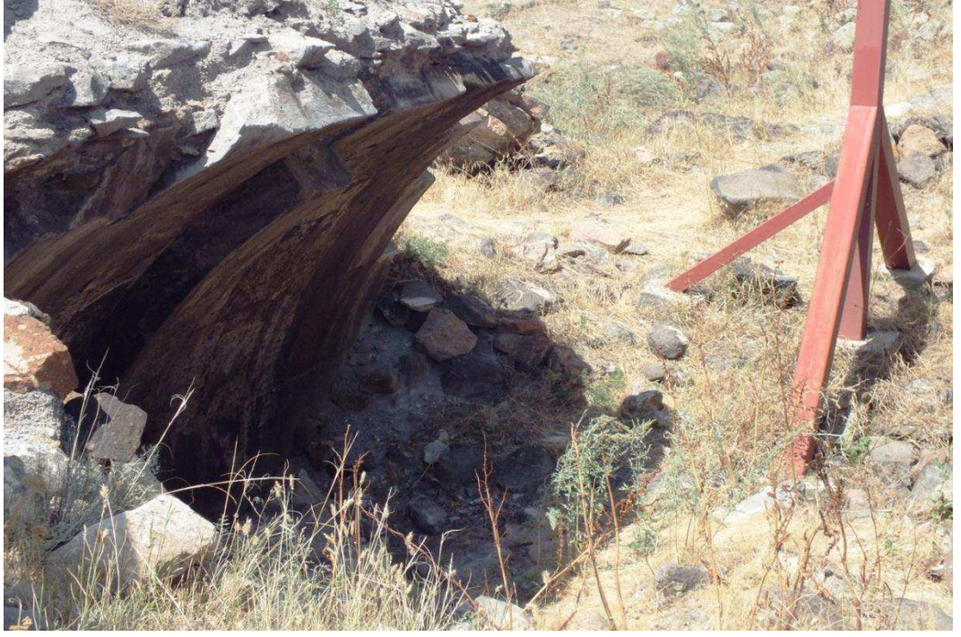
Fot. 5: Gürcü Kilisesi, toprak seviyesi altı katın beşik tonoz örtü kalıntıları.
