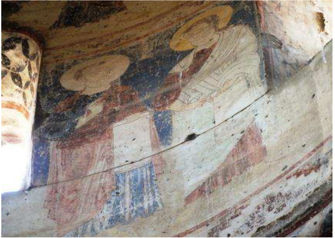
Fot. 214: Resimli Kilise, kubbe kasağı alt kısım duvar resmi.
