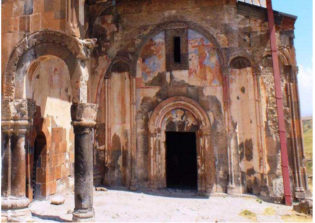
Fot. 62: Resimli Kilise, batı cephesi.
