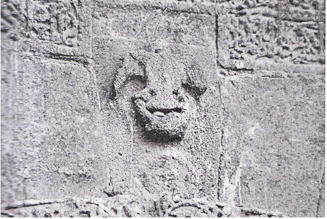
Fot. K. 65: Diyarbakır Kalesi Urfa kapısı kartal figürü.
