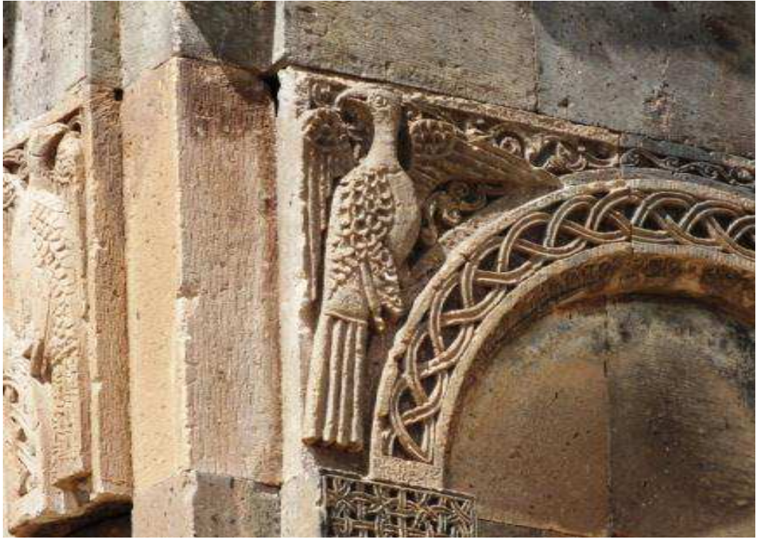
Fot. 72: Resimli Kilise, güney cephe şahin kabartması.
