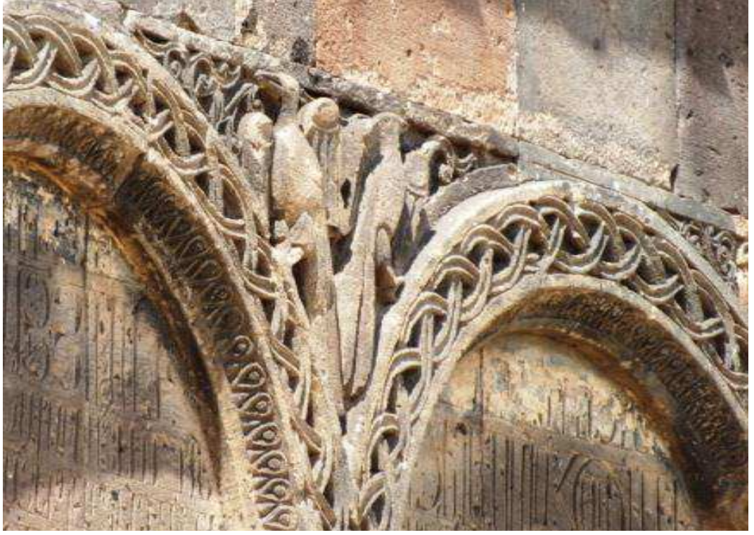
Fot. 81: Resimli Kilise, güney cephe kaz kabartmaları.
