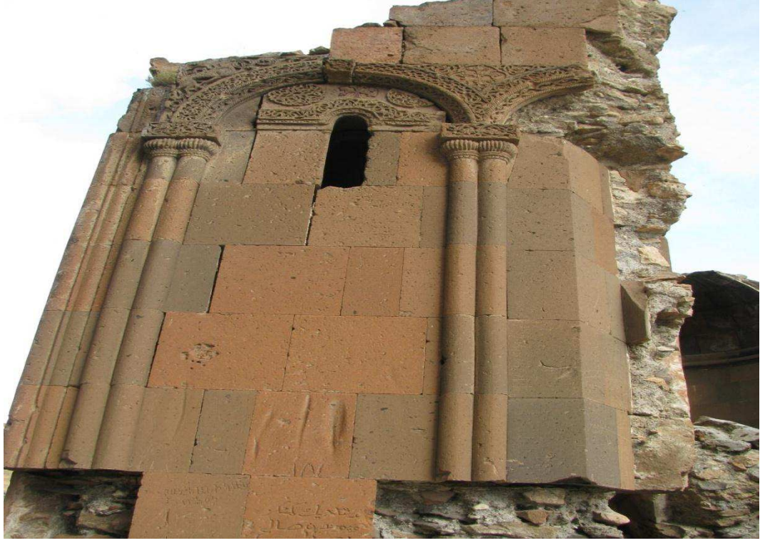
Fot. 37: Kızlar Kilisesi, batı cephesi.
