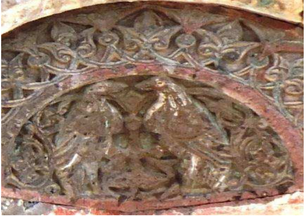
Fot. 69: Resimli Kilise, batı cephe güvercin kabartmaları.
