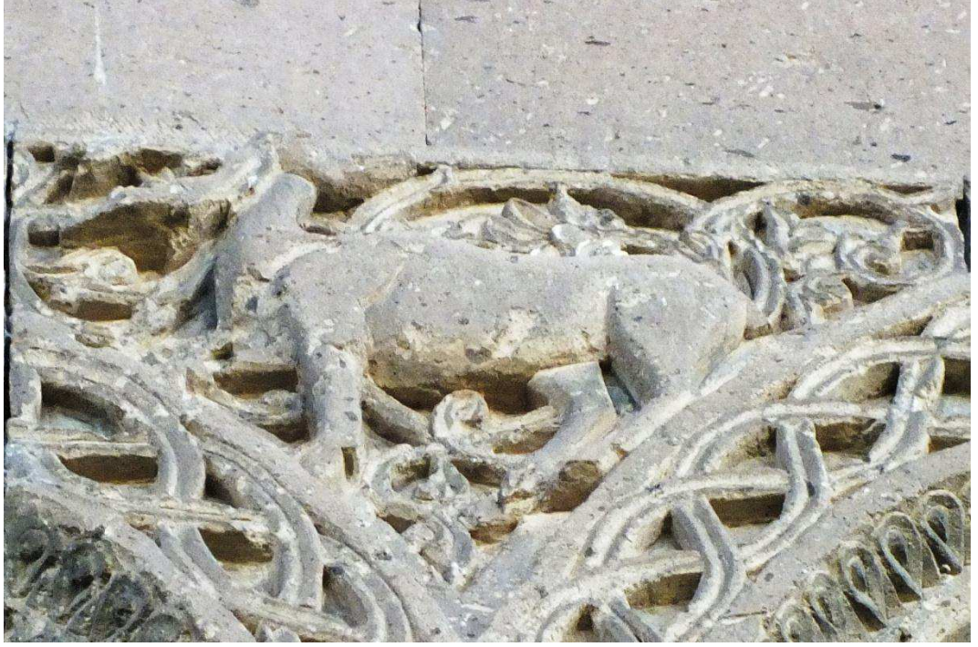
Fot. 77: Resimli Kilise, güney cephe geyik kabartması.
