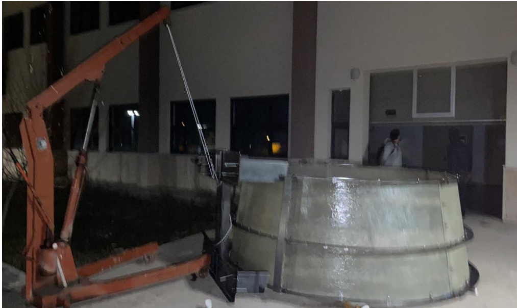
Şekil 6.12. Difüzör dış destekler ve ayak montaj aşaması
